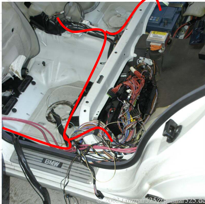
Abbildung 3: Kabelverlauf unter dem hinteren Teppich
